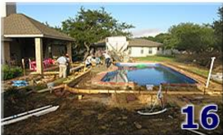
Pouring the deck
