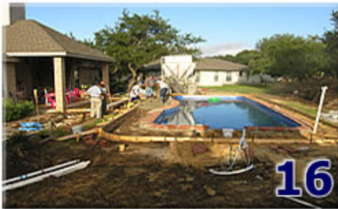
Pouring the deck
